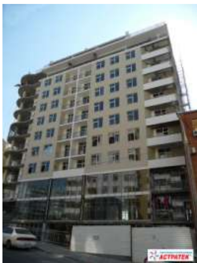
Объект: Жилое многоэтажное здание, г. Геленджик, Краснодарский край (2008 г.)
