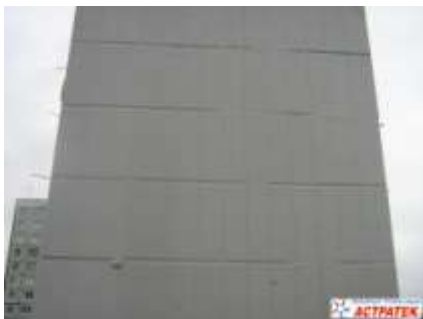
Объект: Жилой многоэтажный дом, г. Фокино, Приморский край (2009 г.)
