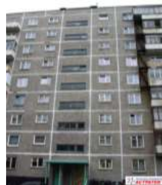
Объект: Девятиэтажный панельный дом (теплоизоляция межпанельных швов), г. Мурманск (2007 г.)
