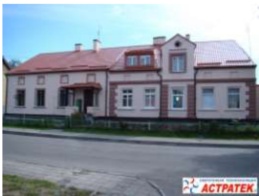
Объект: Жилой дом после нанесения АСТРАТЕК , г. Калининград (2009 г.)
